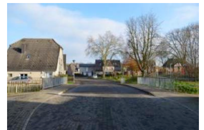
Abb. 96: Brücke und kreuzender Übergang des Selmer Bachs an der Hermannstraße
