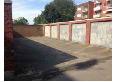
Abb. 158: Bestand Garagenhof an der Fontane Straße
