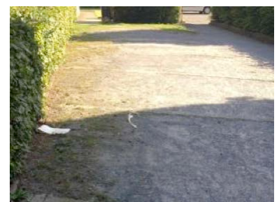
Abb. 168: Schlechter Materialzustand und überschneidende Nutzungen (Parken/Gehweg)
