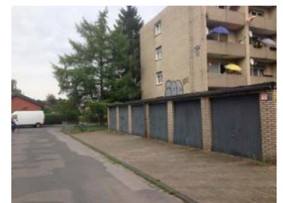
Abb. 192: Verunreinigungen mit Graffiti und sanierungsbedürftige Fassade
