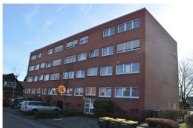
Abb. 73: Straßenansicht Beispielgebäude an der Bernhard-Holtmann-Straße
